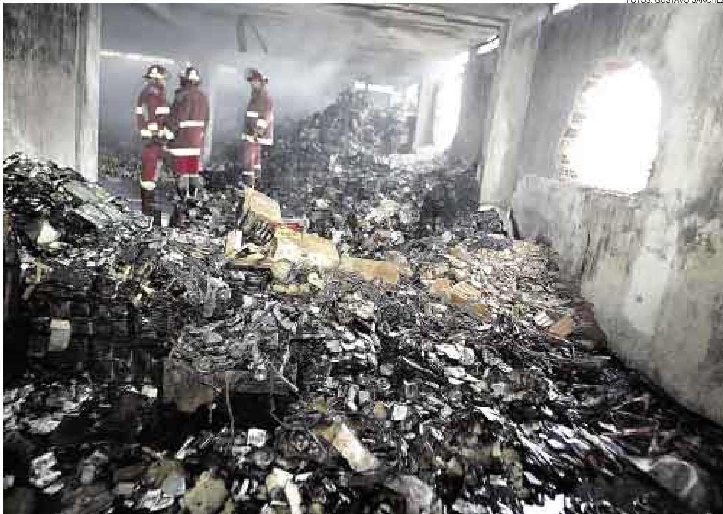
ESCOMBROS. Los pisos altos de la galería Geraldine fueron perforados para combatir el fuego. Al final, la mercancía quedó en cenizas.
