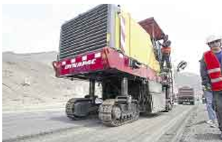
SIN BACHES. Obreros contratados por Emape renuevan la capa asfáltica deteriorada. Los trabajos comprenden 40 kilómetros de carriles.
