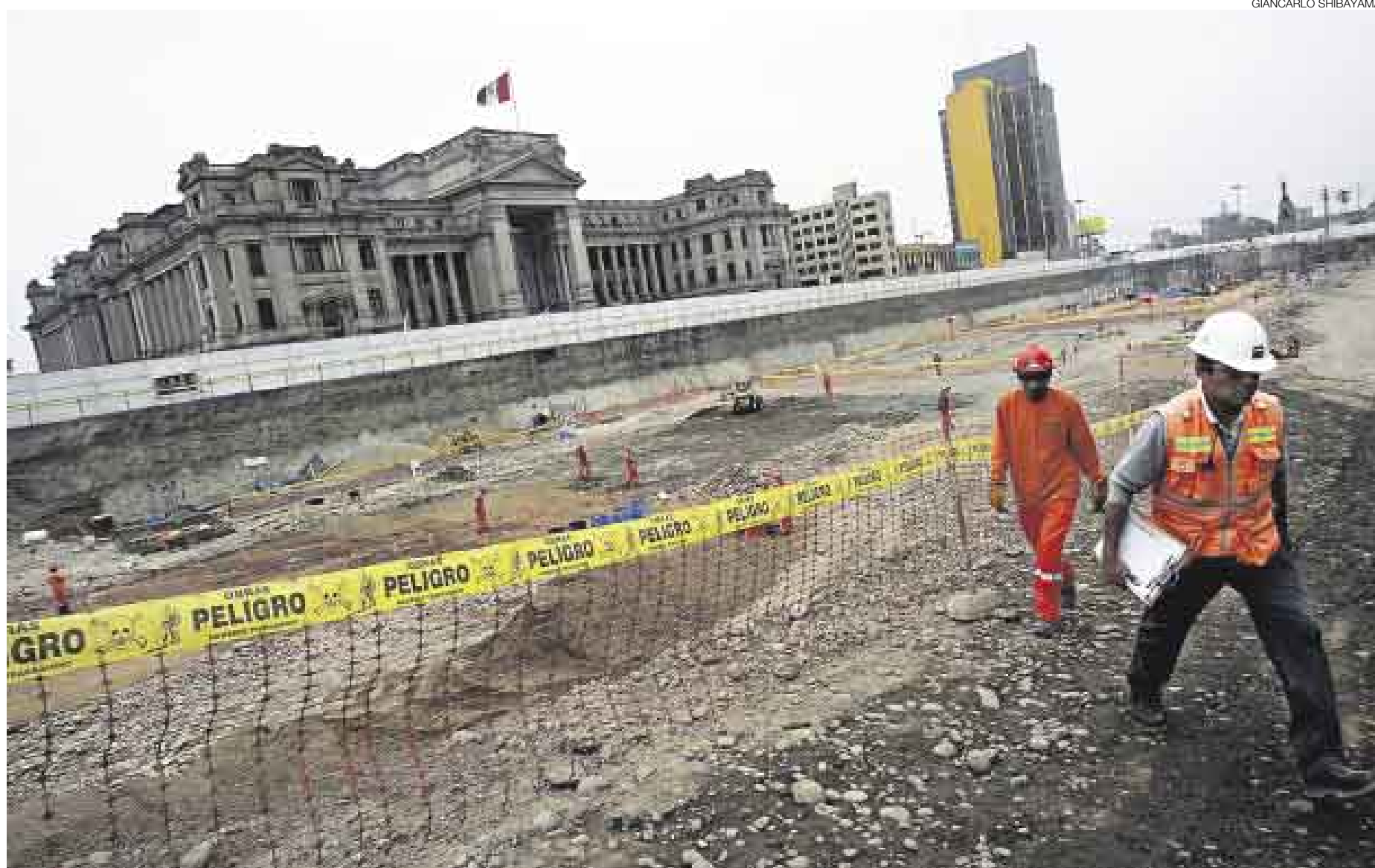
VACÍO MONUMENTAL. La zona donde funcionará la estación central tiene un área de 24.000 m 2 y contará con dos niveles de uso: el primero de ellos tendrá seis metros de profundidad y albergará los carriles vehiculares y el centro comercial; el segundo, de nueve metros de profundidad, servirá de espacio de ingreso y salida del lugar.
