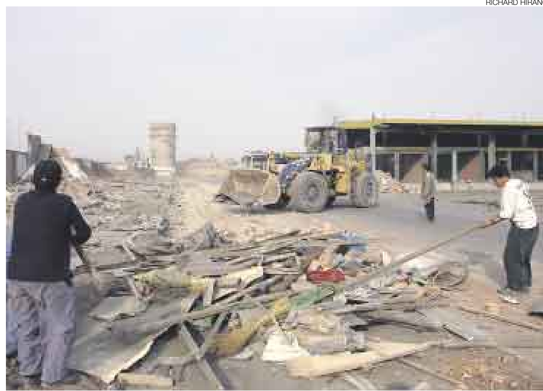
LIMPIEZA. La mayor parte de las construcciones clandestinas ya fue demolida y solo quedan cerros de escombros. Una cuadrilla de obreros y dos máquinas trabajan en el lugar. Labor finalizará en tres semanas.
