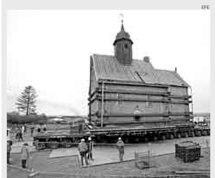
SOBRE RUEDAS. La iglesia de Emaús, de casi 800 toneladas de peso, deberá viajar 12 kilómetros hasta el vecino pueblo de Borna.
