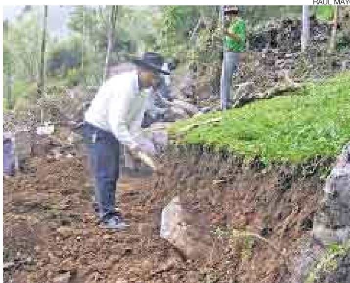
MANOS UNIDAS. Los campesinos se juntan en grupos de veinte para avanzar los trabajos. La nueva vía tiene siete kilómetros de largo.
