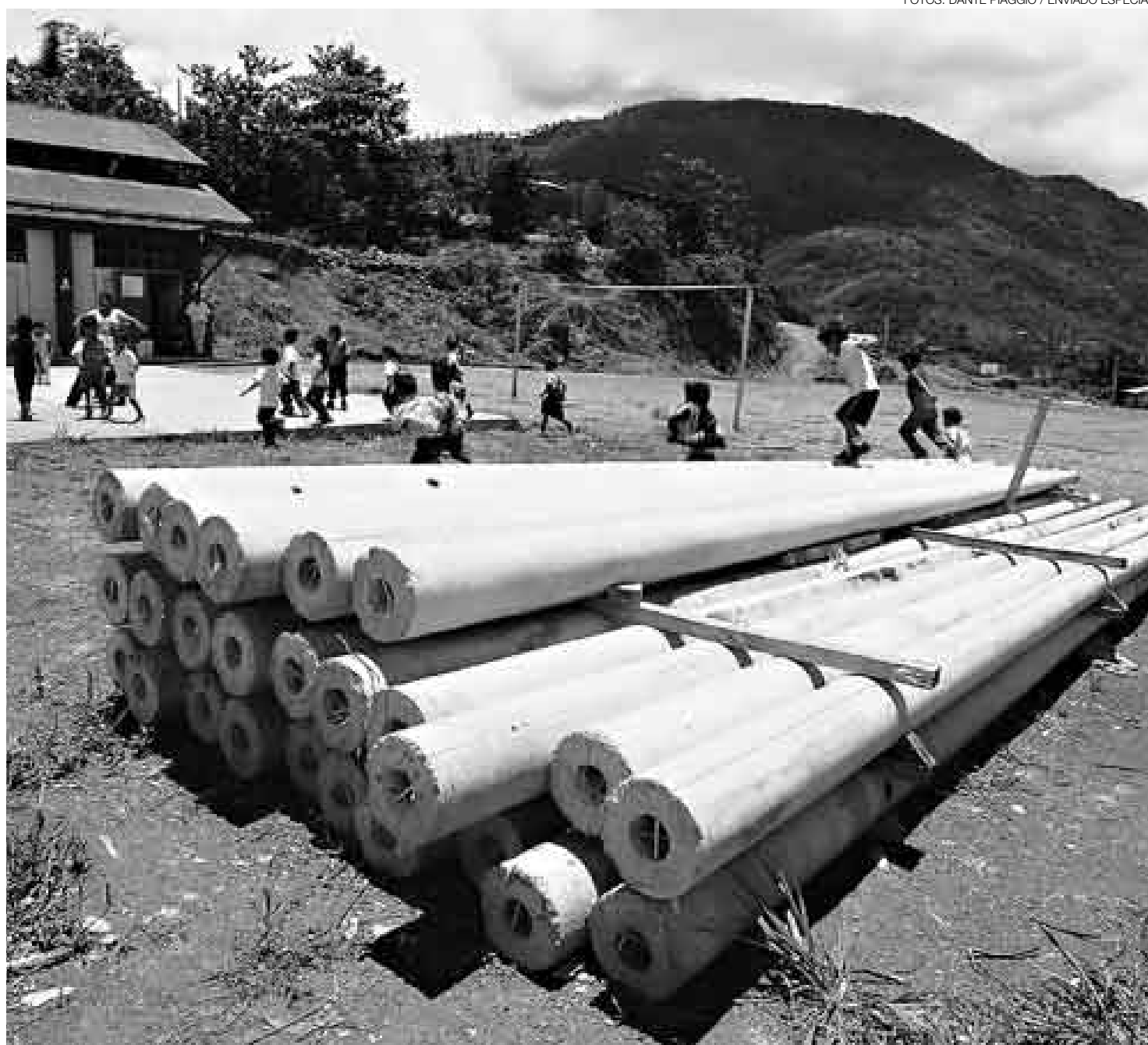
HÁGASE LA LUZ. La futura instalación de postes a lo largo de la carretera de acceso al VRAE forma parte del proyecto de electrificación que dará luz a gran parte de este valle cocalero a partir del próximo año. Las poblaciones que se asientan en el lugar serán las más beneficiadas.
