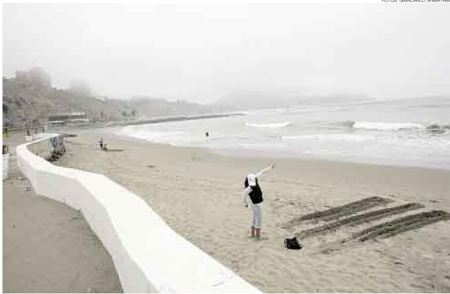
COSTA CHICA. El espacio público marino de la Costa Verde sigue transformándose para tristeza de muchos veraneantes que ven recortado el espacio de playa. El malecón construido en Barranco deberá rehacerse debido a que presenta fallas estructurales.
