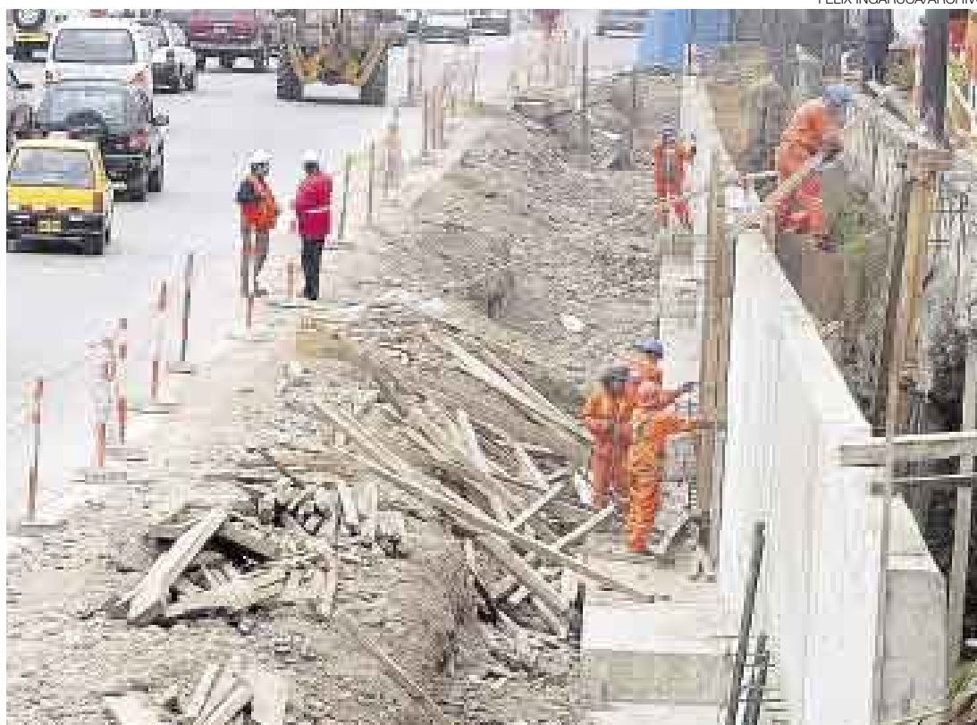
A TODA MARCHA. Las obras en la Vía Expresa del Paseo de la República explican parte del incremento en la compra de cemento. El sector construcción fue el de mayor expansión en octubre con 19,87%.
