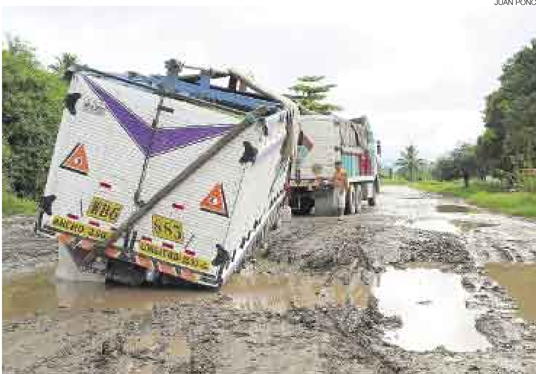
PERJUICIOS. Debido a las fuertes lluvias, muchas carreteras de la sierra y la selva han quedado en estado lamentable, como se aprecia en esta imagen captada hace una semana en la vía que une Saposo con otras ciudades de la selva.
