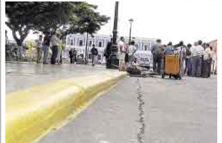
DETALLE. Los trabajos contaron con autorización municipal.
