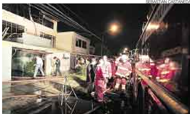
AFECTADOS. La vivienda 776 de la calle 9 en la urbanización Córpac, en San Isidro, se vio afectada por un incendio, cuyas causas se desconocen.
