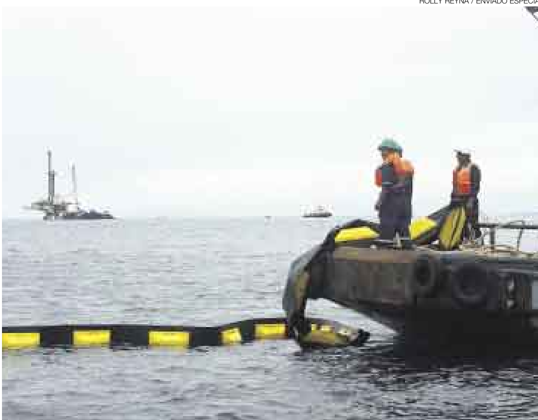
ALTO AL DAÑO. Las cinco barreras de contención tienen como misión evitar que el petróleo ubicado en la superficie del agua siga esparciéndose. La suave marea favorece el trabajo de estos instrumentos.
