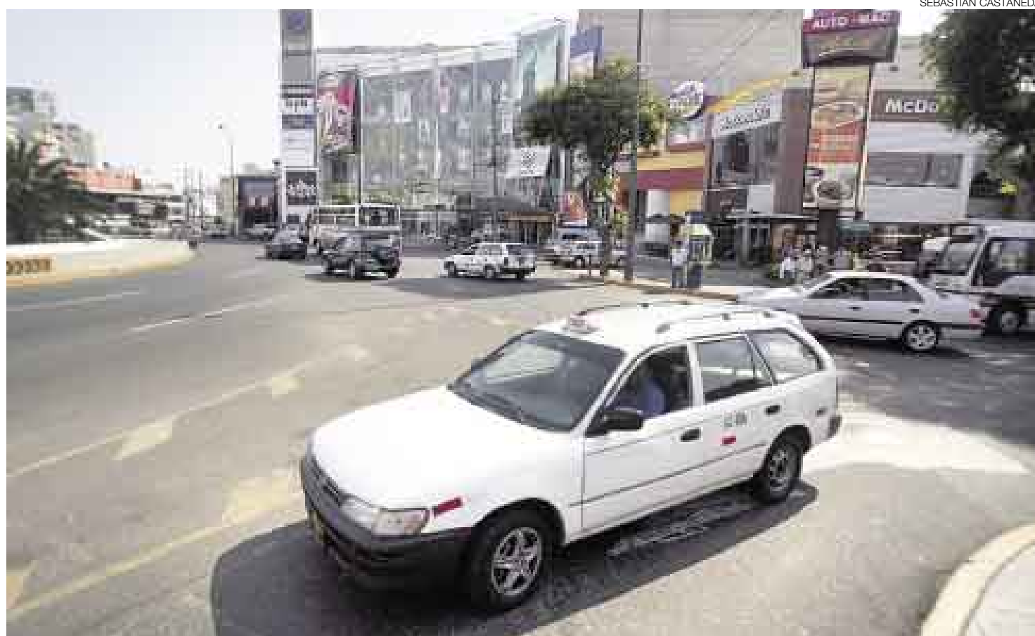
VÍA CONFUSA. La intersección de la Av. Cavenevia tiene un giro a la izquierda cuyo carril se debe delimitar nuevamente para seguridad del peatón.
