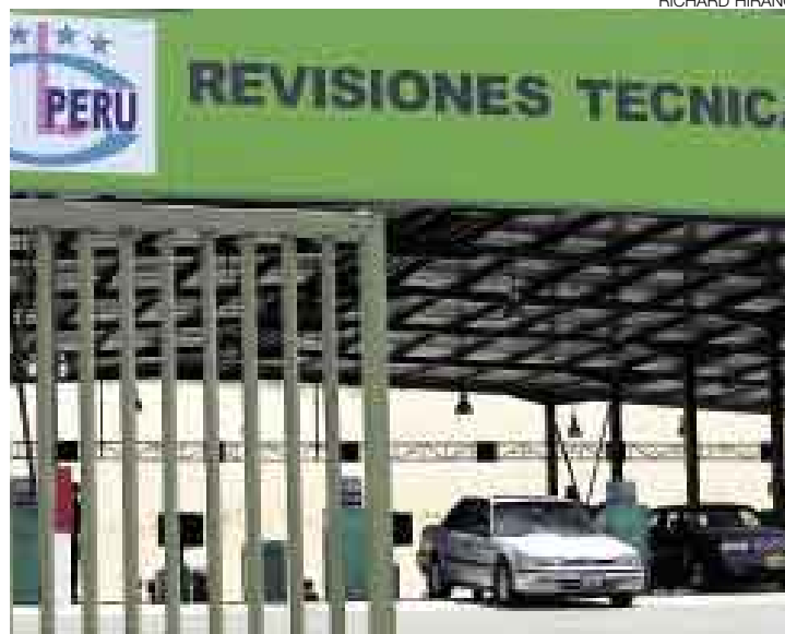
TRABAJARON. La planta de Villa El Salvador recibía un promedio de 700 vehículos al día. Tras el anuncio del concejo, solo llegan 150 unidades.
