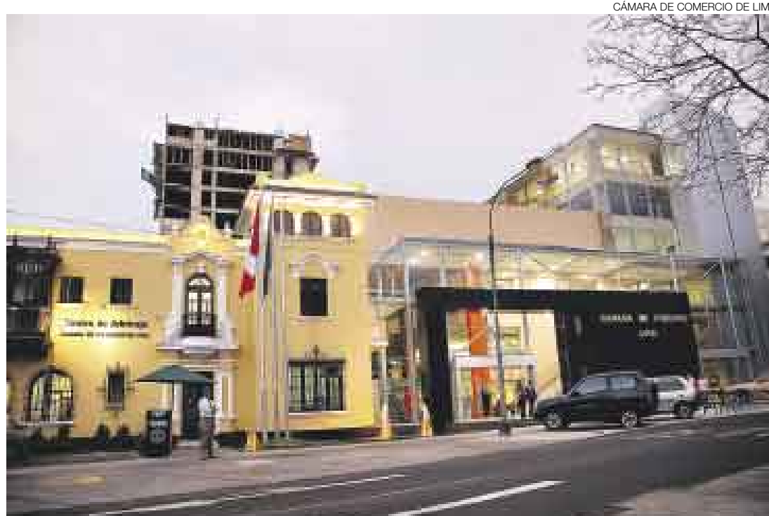
UNA DE LAS SEDES. El moderno edificio de la Cámara de Comercio de Lima (CCL), en Jesús María, será una de las tres sedes que albergará a los funcionarios de las 21 economías de la APEC durante el SOM-I.
