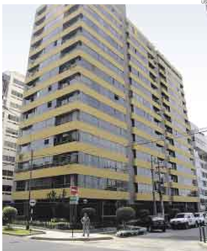
CAÍDA MORTAL. De este edificio en San Isidro cayó Víctor Eyzaguirre.
