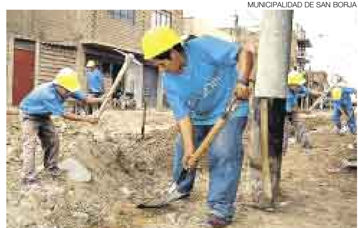
■ CAMBIOS. Además de construir pistas y veredas, se rehabilitarán parques.
