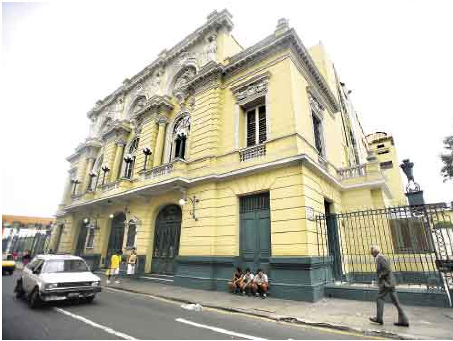
OLVIDO. Los salones que se salvaron del incendio conservan su fastuosidad. En los exteriores del teatro, ubicado en el Jr. Ica 377, lo que hay es desorden.
