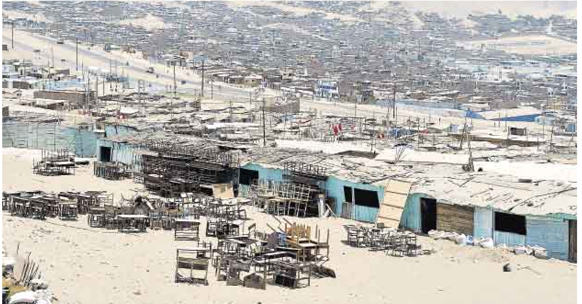
COLAPSADO. El colegio José Andrés Rázuri Estévez, en Ventanilla, espera aún el presupuesto asignado para reparaciones. Cinco aulas colapsaron tras el terremoto del 15 de agosto y no se han reparado desde entonces. Los alumnos de educación secundaria tendrían que empezar sus clases a la intemperie y soportando el intenso sol.
