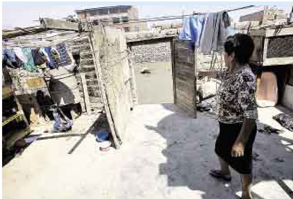
DE PUERTA AL RÍO. Casi todas las viviendas del asentamiento humano Kuélap, en Puente Piedra, tienen una puerta que da directo al río. El concejo les dio certificados de posesión pese al peligro.
