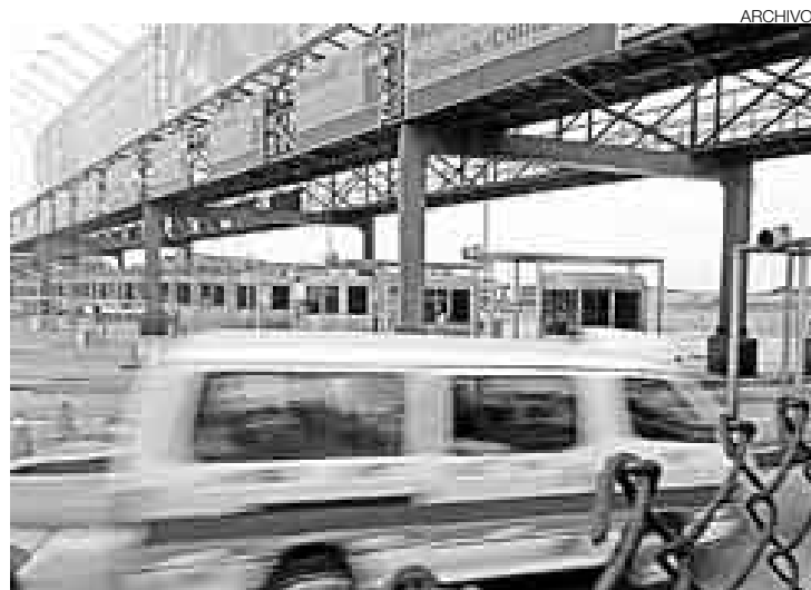
VÍA BAJO LUPA. La contraloría entregará pronto a la fiscalía un peritaje que ha desarrollado sobre las cuestionadas obras en la avenida Faucett.
