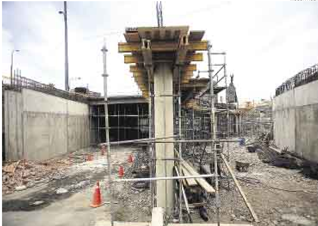
ESTACIÓN CENTRAL. Esta es la única obra que a la fecha se está ejecutando en el nuevo corredor vial. Aún no se ha iniciado la licitación para elegir a la empresa que se encargará de construir los otros paraderos o estaciones.
