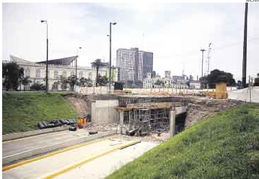
EN ESPERA. Las obras de construcción de la Vía Expresa ya habrían culminado en su primera etapa; sin embargo, aún faltan los paraderos y que los buses empiecen a funcionar. La situación, en realidad, es incierta.
