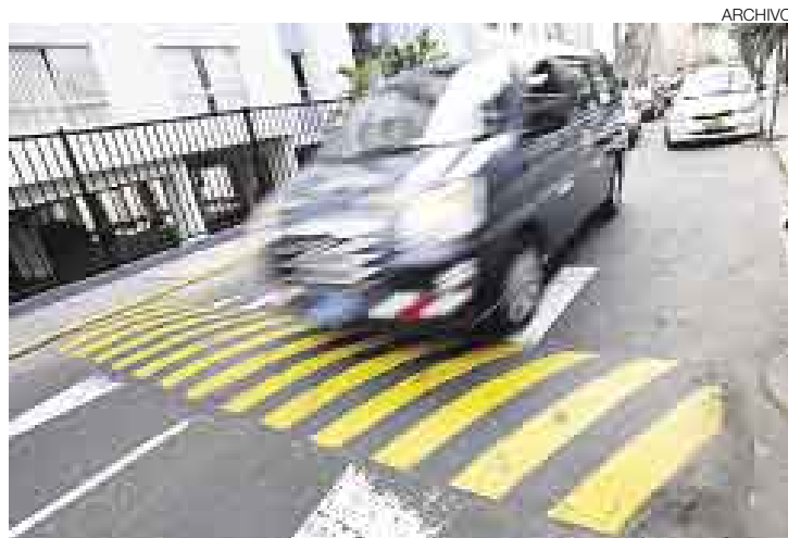
NOCIVO. Rompemuelles inapropiados causan daño a los vehículos.
