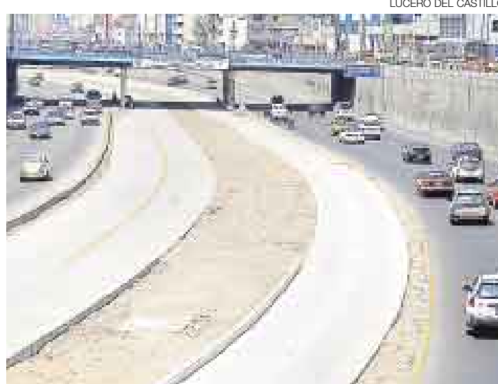
AQUÍ NADIE TRABAJA. Desde que en febrero culminó la construcción de la berma central del Cosac, las obras se encuentran detenidas.
