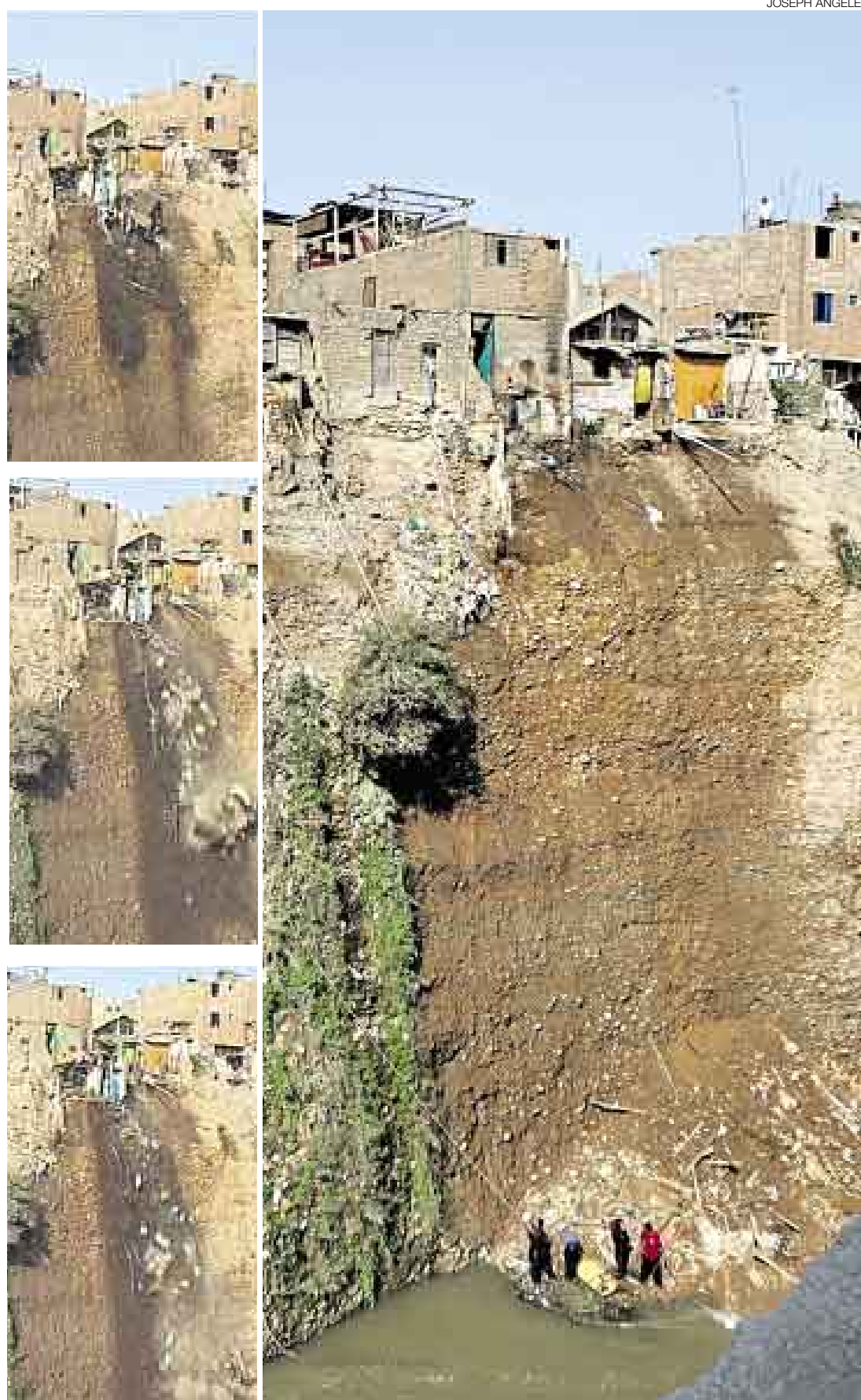
DE CARA AL ABISMO. Las imágenes de la izquierda, captadas por Canal N, muestran el momento en el que la casa de Jhon Garay se viene abajo. A la derecha, los socorristas colocan a Jhon, aún con vida, en una camilla.
