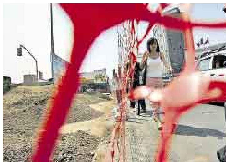
DESVIOS. El tramo final de la Av. Arequipa fue cerrado para poder rehabilitar la vía. Esta es una de las obras que complica el tránsito en Lima.
