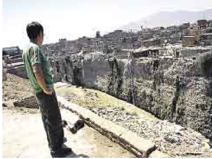
HORIZONTE BALDÍO. A falta de un sistema legal de desagüe, los habitantes de la zona han construido improvisados colectores.
