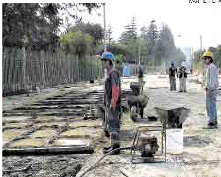
APURADOS. El personal a cargo de las obras en la avenida Petit Thouars esperaba terminar el asfaltado de las nueve primeras cuadras durante la noche.
