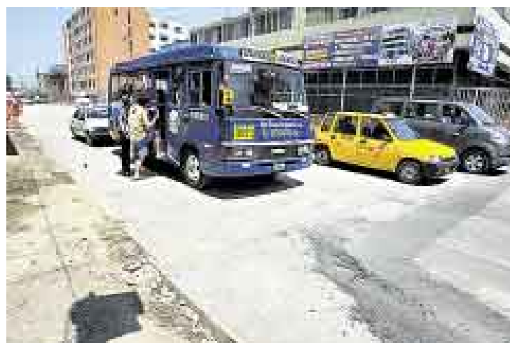
SIN ASFALTAR. Así lucen cinco de las nueve primeras cuadras de la Av. Petit Thouars. Se espera que hoy terminen de colocar la capa asfáltica.
