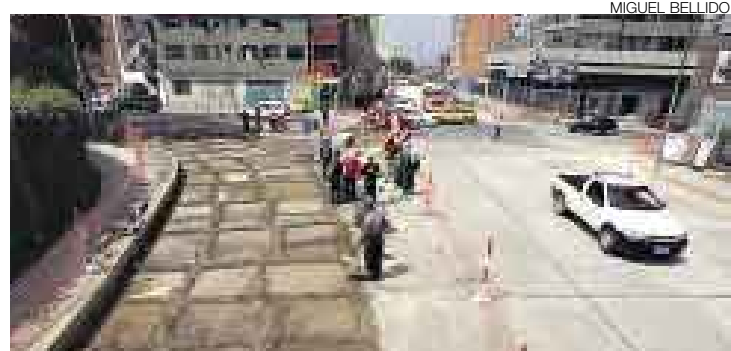
A TODA MÁQUINA. A la altura del cruce de la avenida Emilio Fernández, los obreros seguían trabajando en la avenida Petit Thouars.
