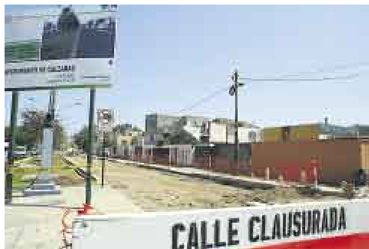
¿Y AHORA? Las avenidas Vallejo y Cádiz, desvíos para las obras de Javier Prado, están cerradas en varias cuadras por proyecto sanisidrio.
