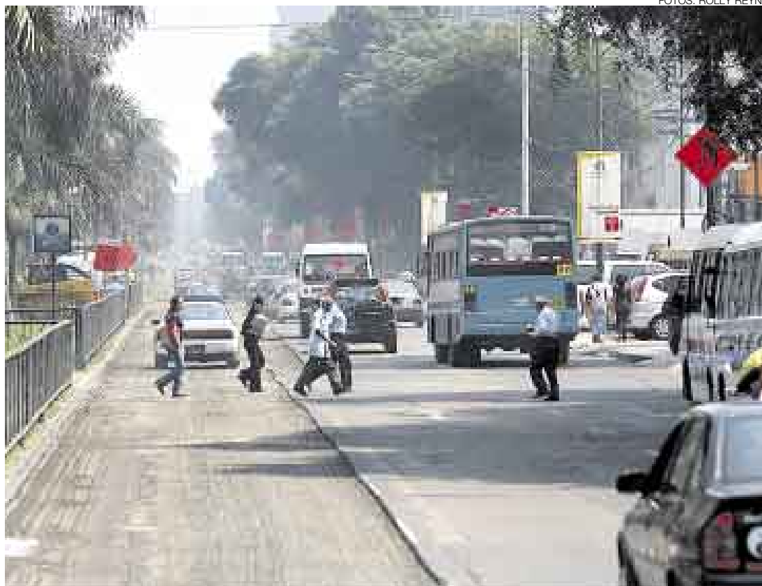
DESPELLEJADA. La Municipalidad de Lima inició la refacción de la Av. Javier Prado Oeste entre las cuadras 3 y 10. El tránsito quedó restringido solo durante la noche y en el carril en el que se efectuaban los trabajos.
