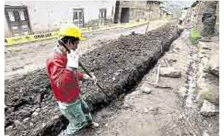
AGUA POTABLE. Una de las obras más esperadas ha sido la instalación de las redes de agua potable, sobre todo en la zona sur, la más pobre.
