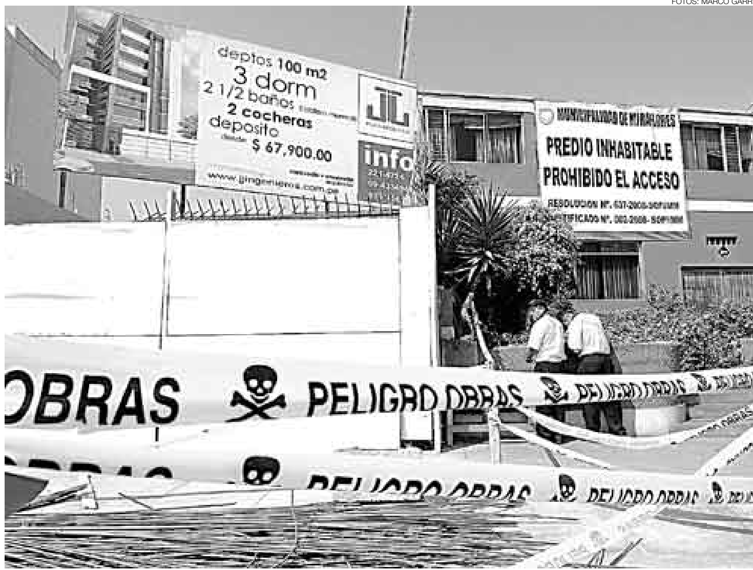
EN VILO. La Municipalidad de Miraflores realizó ayer una nueva inspección en la vivienda afectada por el derrumbe, la cual se está apuntalando.
