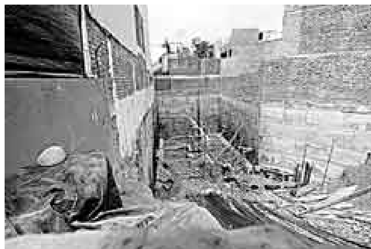
A LA MALA. El concejo notificó primero la paralización de las obras de J J Ingenieros, como esta, situada en la cuadra 3 de la calle Aviación.
