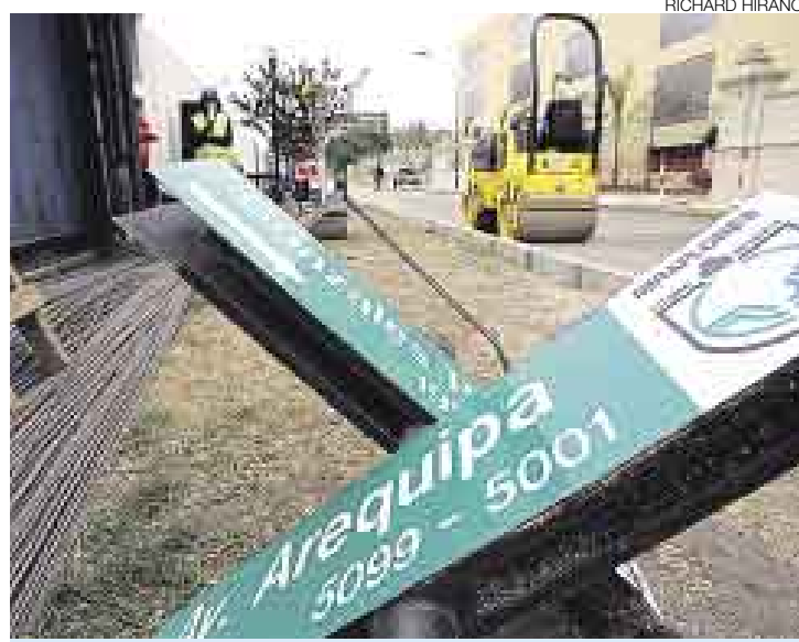
ÚLTIMOS TOQUES. Obreros realizaban ayer los trabajos finales de asfaltado en las cuadras de la avenida Arequipa próximas al óvalo de Miraflores.
