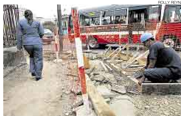
POR HACER. La renovación de veredas en las últimas seis cuadras de la avenida Arequipa acaba de empezar. Los peatones deben tener cuidado.
