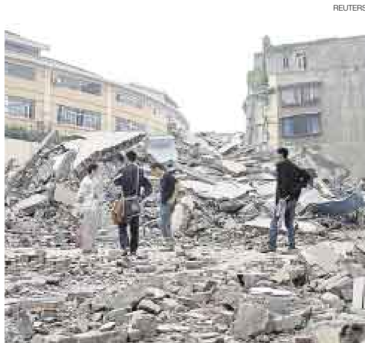
MUCHO POR HACER. A la cantidad de muertos se suman los grandes daños a las edificaciones de las zonas afectadas por el sismo.
