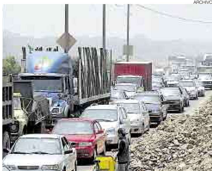
EN OBRAS. El Ministerio de Transportes y Comunicaciones ha recuperado ya una parte de la pista de ingreso a la vía Carapongo-Naña.
