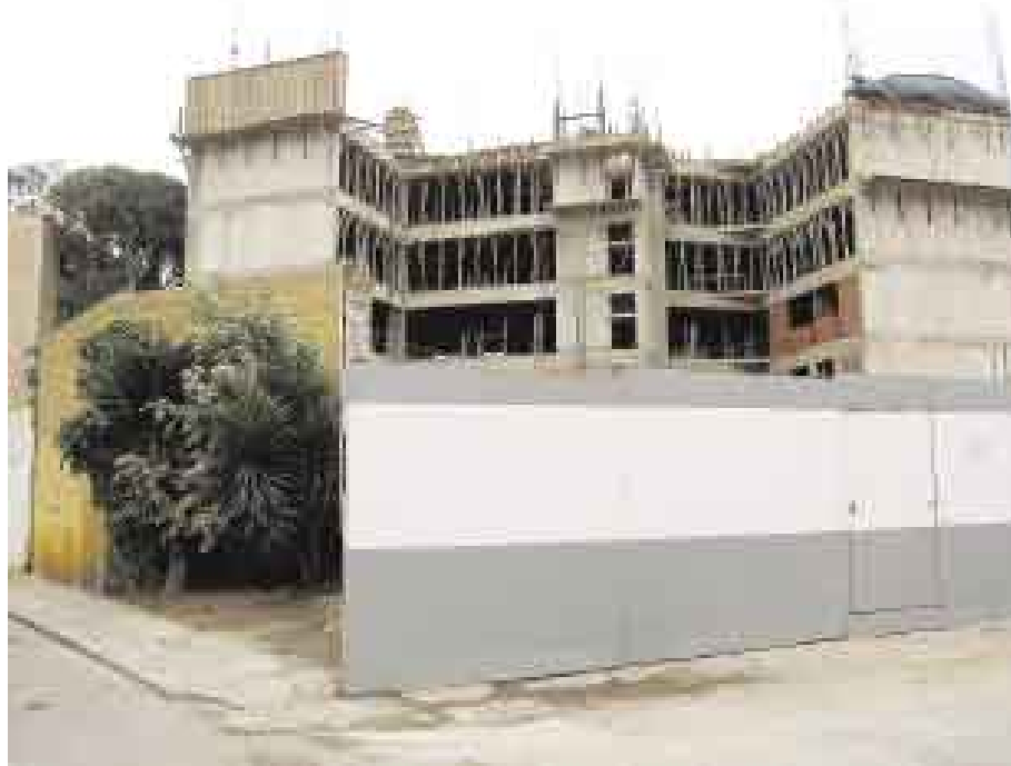
LLEGAN. MEGAPROYECTOS DE 10.000 VIVIENDAS SE AVISORAN EN EL HORIZONTE.
