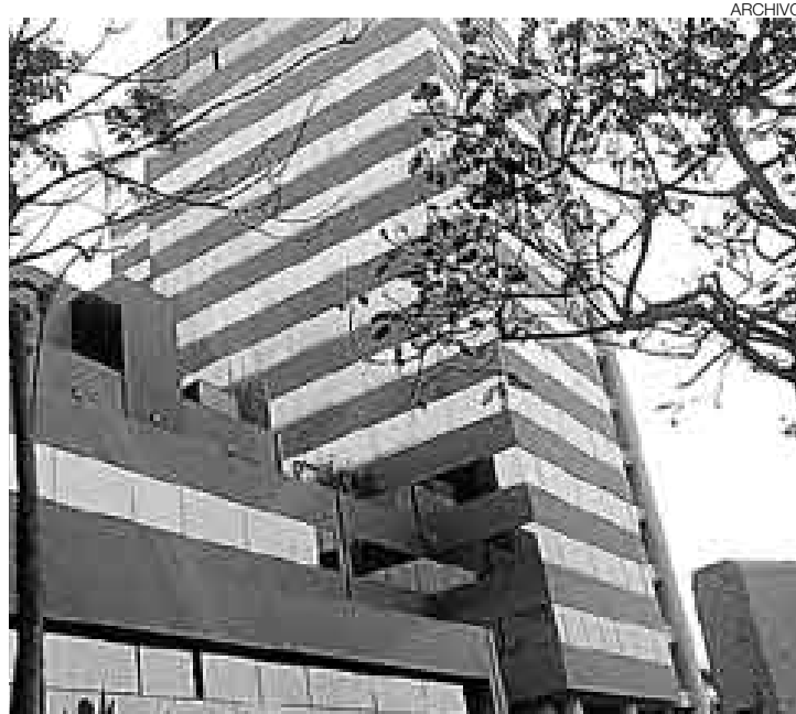
¿OFERTA NUEVA? La sede del desaparecido Banco del Nuevo Mundo, con 5.629 m 2 de oficinas, paliaría parte del déficit en Lima este año.
