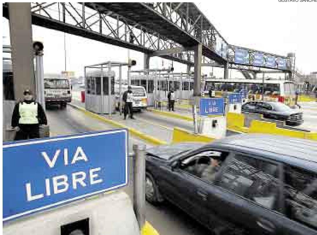
PASE LIBRE. La vía expresa Faucett amaneció ayer con las casetas de peaje cerradas. Obreros municipales retiraron 15 rompemuellas para agilizar el tránsito y reemplazaron los letreros de tarifas por uso de la vía.
