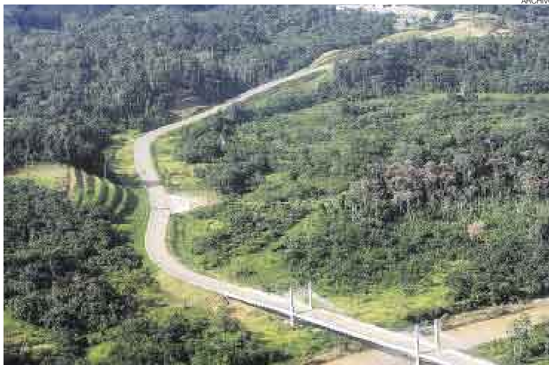
¿PRECIO REAL? En el tramo que va de Urcos hasta el puente Inambari hay campamentos para los trabajadores que habrían costado seis millones de dólares, según declaración de la constructora.
