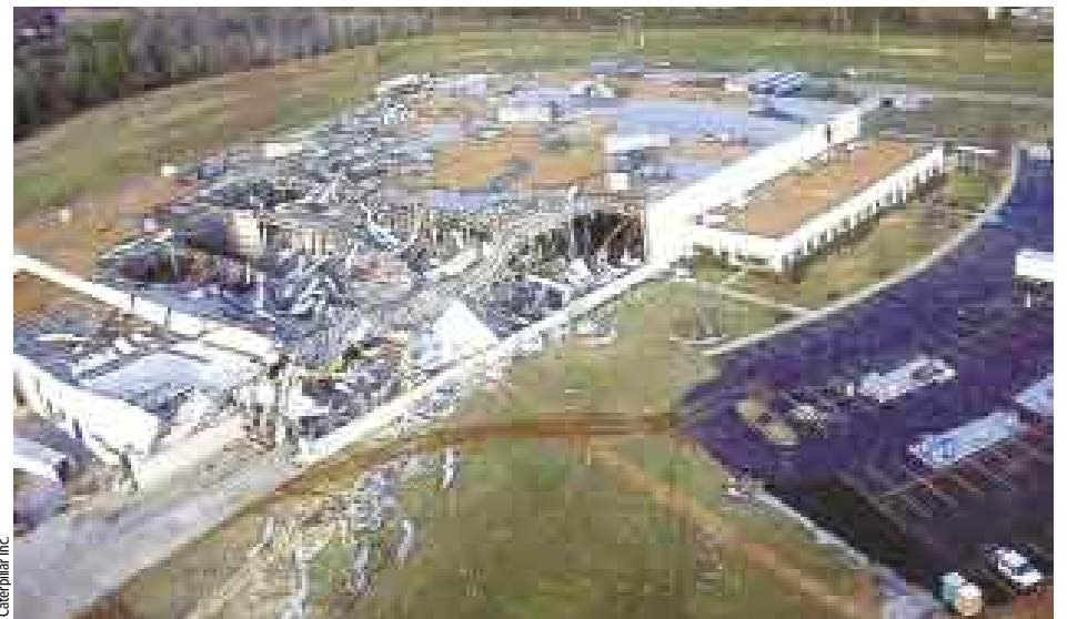
La fábrica de Caterpillar en Oxford, Mississippi, tras el paso de un tornado en febrero.
