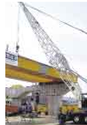
HABICH. LA ESTRUCTURA METÁLICA FUE HECHA POR FIANSA.
