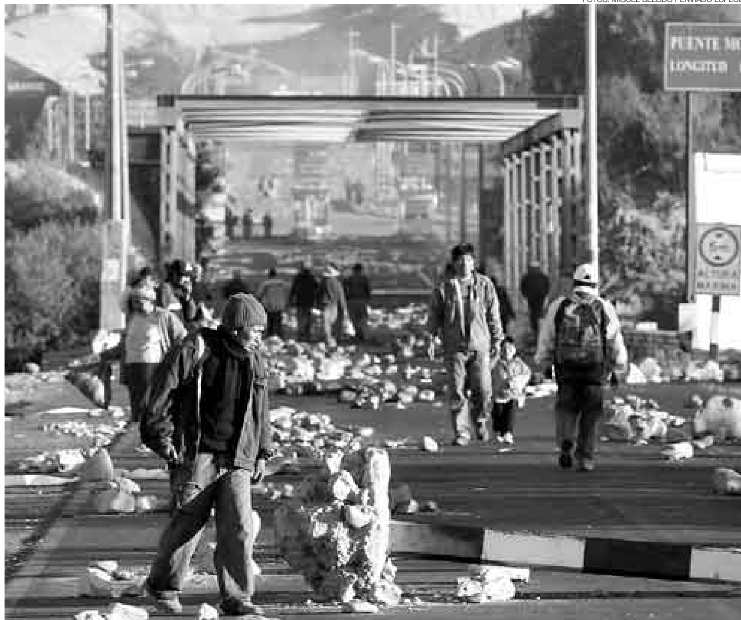
BLOQUEADO. La crisis continúa. El puente Montalvo permanece bloqueado y Moquegua y Tacna permanecen aisladas. Van nueve días de huelga.
