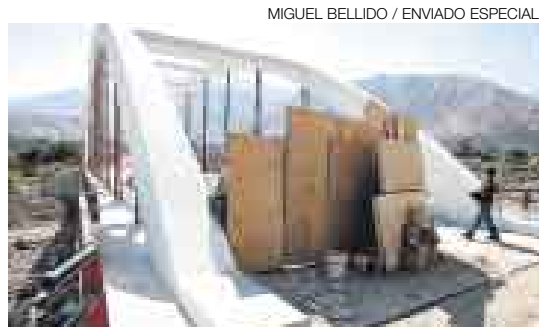
ILEGAL PARED. Para bloquear el puente Montalvo, en Moquegua, ya no se utilizan solamente piedras.
