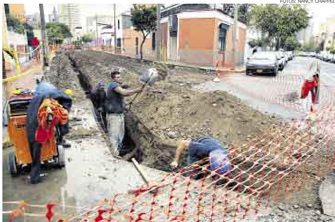
EN BERLÍN. En esta calle mirafloresina también se arreglarán veredas dañadas y se colocarán farolas y papeleras.
