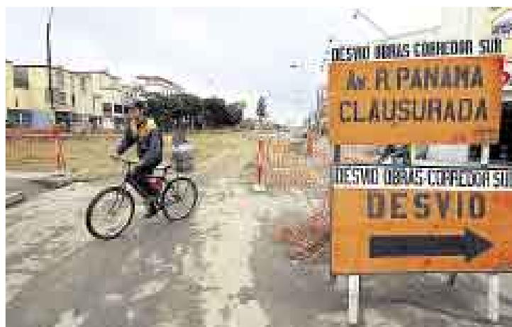
BARRANCO. Así permanece la obra en la Av. República de Panamá.
