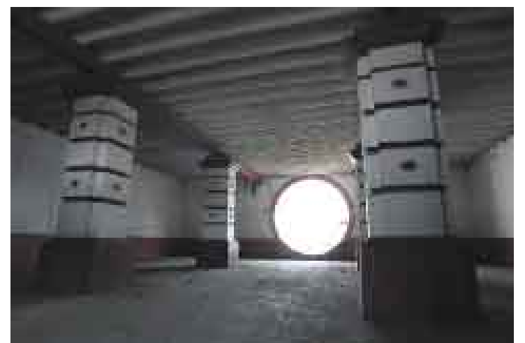
ABANDONO. En San Luis se asentaron los chinos con sus construcciones.
